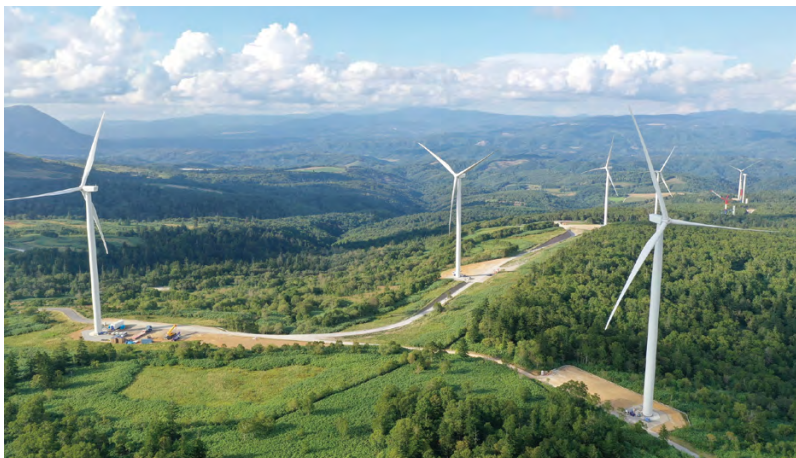
留寿都風力発電所（留寿都ウインド合同会社）（日本）
